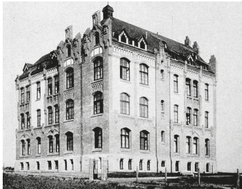
Bürgerengagement in Stein gemeißelt: Der erste Bauabschnitt (1904)
